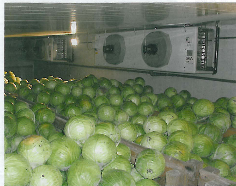
Die Verdampfer sollten regelmäßig auf ihre Funktionstüchtigkeit überprüft werden
